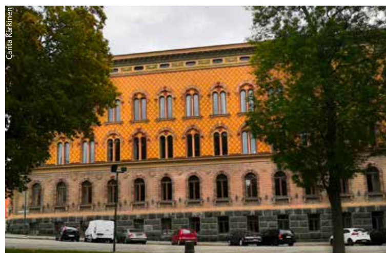
Porin kaupungintalo, tunnetaan myös nimellä Junneliuksen palatsi rak.v.1895. Arkkitehti August Krook.
