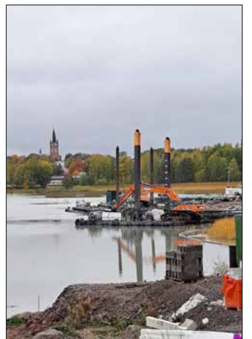
Tulevien kelluvien talojen rakentamisaikaa ruopataan.
