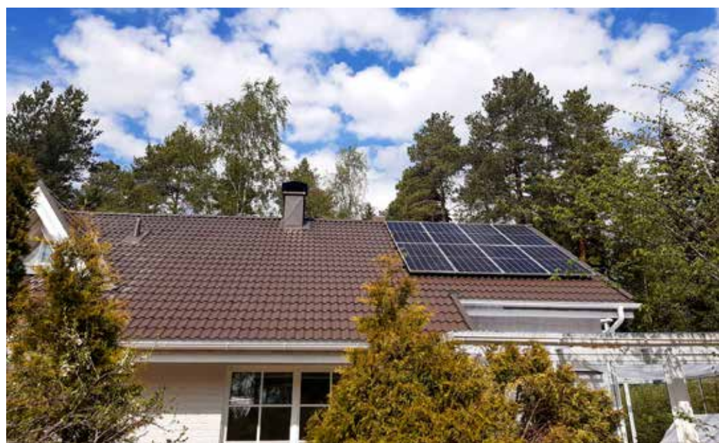
Aurinkopaneelit omakotitalossa energiaa säästämässä.
