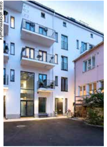
Toritalon sisäpihaa Kotkassa, viihtyisää asumista keskustassa. Arkkitehti Jani Prunnila 2019.
