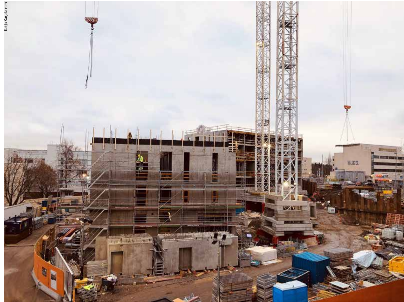
Asuntorakentaminen käynnissä Malmin asemalla Helsingissä.
