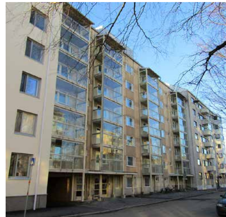
Peruskorjattu kohde, Kirkkopuistikko 32 A/B. Kuva: Pikipruukki, arkisto.
