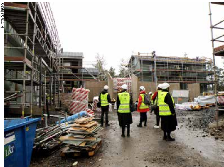
Rakenteilla olevia vuokra-asuntoja, Naantalin Vuokratalot Oy. Kohteet rakennetaan savuttomiksi.
