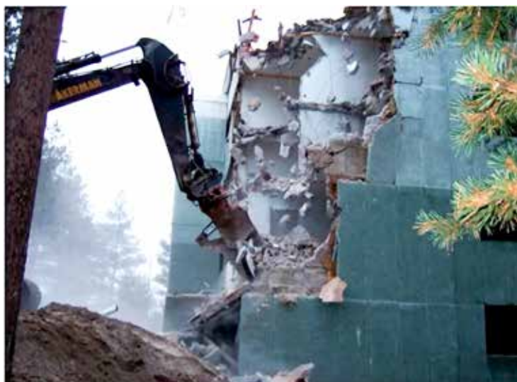
Kemijärven ensimmäinen kerrostalon purkutyömaa vuonna 2006
