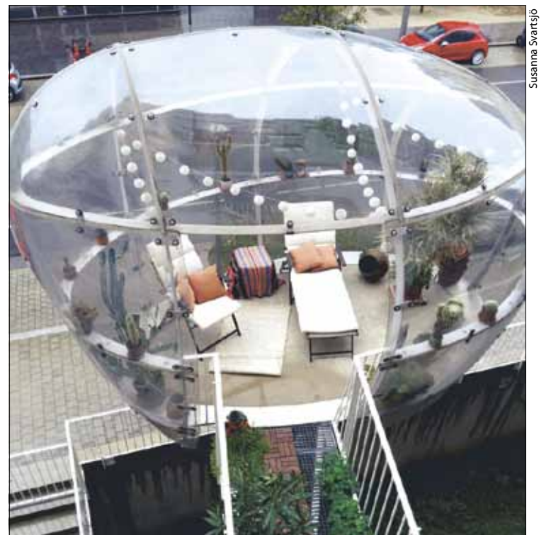
Nordbahnhofin asuinalue. Kuplat talon edessä korvaavat asuntoparvekkeet lisäten oleskelutilaa. Talon edustan istutukset ovat kuplien alla katutasoa alempana.
