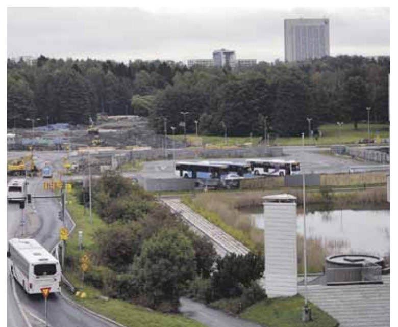
Tapiola on nykyisin rakennustyömaa. Rakentaminen jatkuu vuosikymmenen loppupuolelle.
