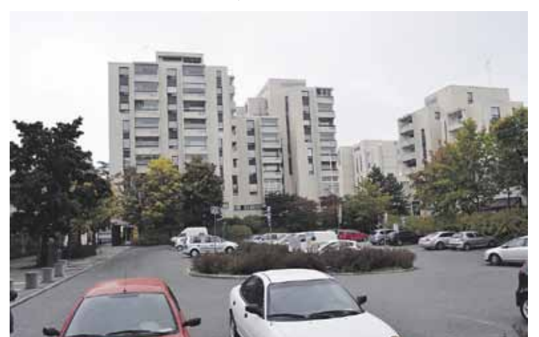
Asemakaavan muutosehdotuksen mukaan lähes kaikki Tapiolan keskustan nykyiset rakennukset puretaan.
