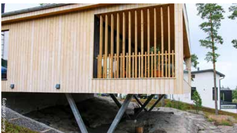
Palokärki-talo on rakennettu osittain metallisten tukien päälle.
