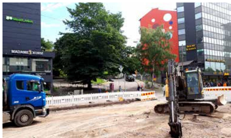
Ilmanlaatu ja melu kaupunkien työmailla erityistarkastelussa. Infra-hankkeita on paljon.
