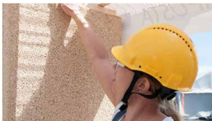
Hampurakentäminen syntyy kalkista, hampusta ja vedestä valettavasta massasta. Rakenteen pintaan sopivat hengittävät rappaukset, maalit sekä puuverhoilu.
