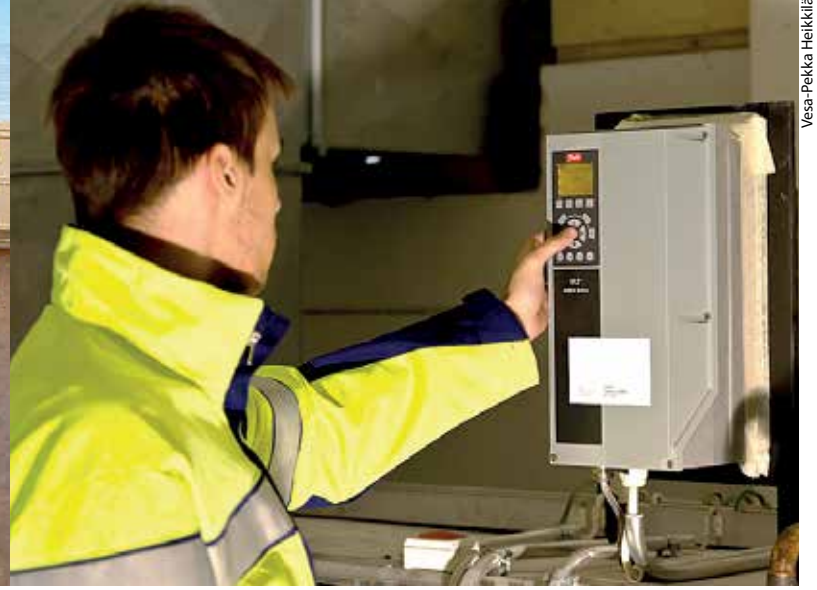
Kiinteistön toiminnan seuranta on tärkeä osa kiinteistöhoitajan työtä.
