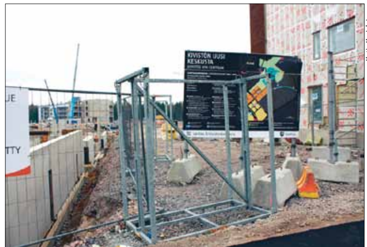
Vantaan Kivistön uusi keskusta rakentuu Marja-radnan yhteyteen.
