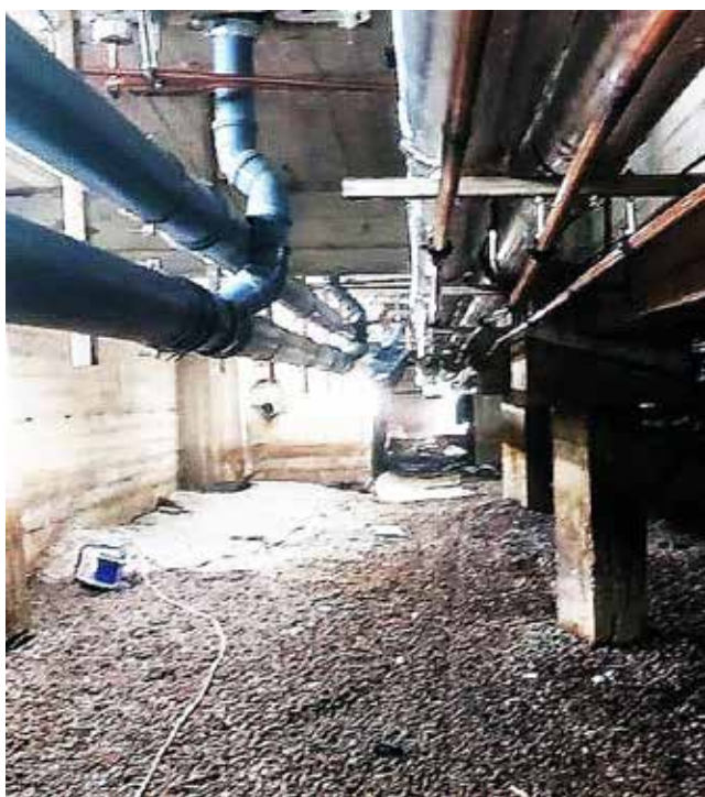
Pimeä, mutainen, katosta vettä tippuva alapohja on nyt valoisa, siisti ja kuiva. Vanha vesiraja näkyy kivijalassa. Jatkuva olosuhdeseuranta tapahtuu radioteitse. Kuva: Teholämpö Oy .
