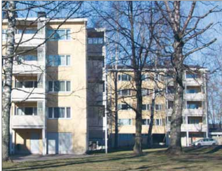
ARA-talo Roihuvuori Prinsessantie.
