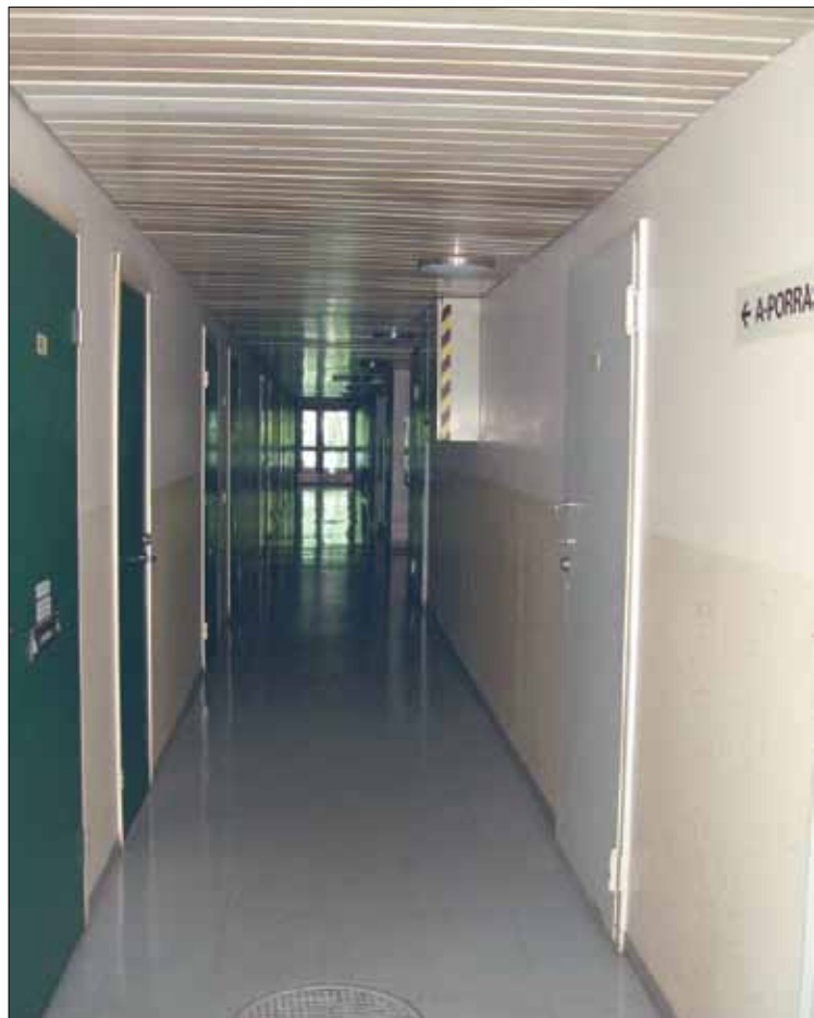
Vuokratalon käytävä muistuttaa hotellin käytävää, jossa pienet asunnot ovat käytävän kahta puolta. Talossa ei ole hissiä eikä asunnoissa parvekkeita, mutta neliövuokra yli 26 euroa.
