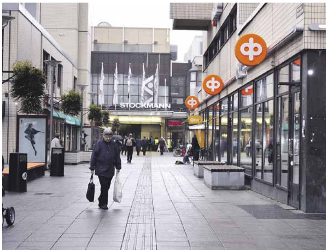
Tapiolan Stockmannin tavaratalo vuodelta 1981 puretaan. Rakennuksen on suunnitellut arkkitehti Bertel Gripenberg.
