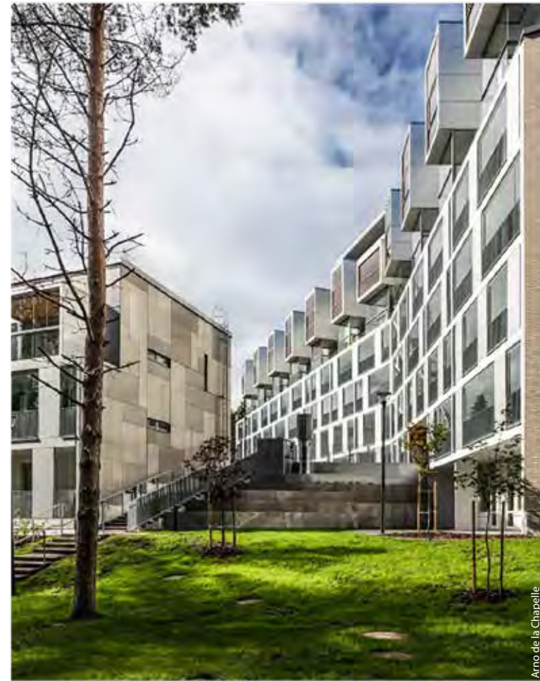
Palkittu uudisrakennus Mellunmäessä, Pyhätunturintie 2.
