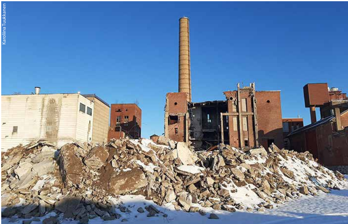
Hiedanrannan purkukohde. Syntyy purkumateriaalia myös katurakentamiseen.
