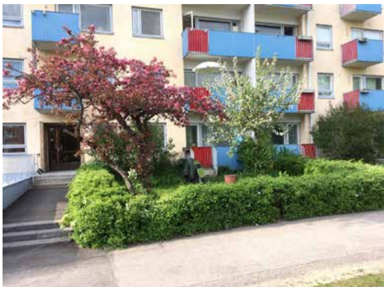
Arkkitehtuurin professorin ja Helsingin kaupunginarkkitehti Hilding Ekelundin suunnittelema kohtuuhintainen aravatalo 1960-luvun alusta.
