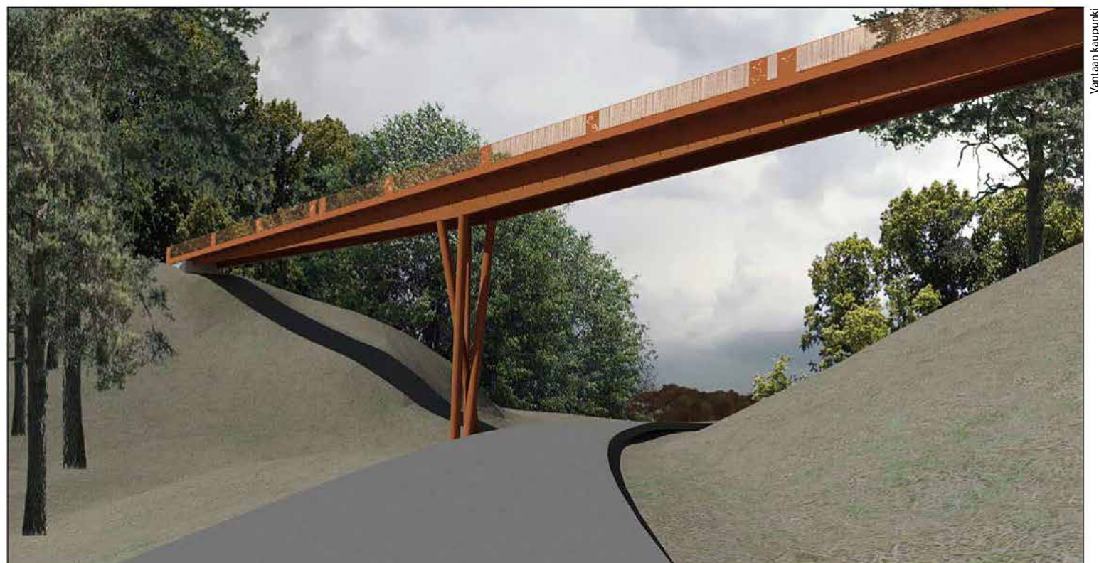
Vanhan Porvoontien keveyden liikenteen ylikulkusillan yleissuunnitelma on laadittu WSP Oy:ssä. Silta rakennetaan pääosin betonista ja teräksestä, mutta sillan kansi on puuta. Silta saa ruskean värinsä corten-teräksestä.
