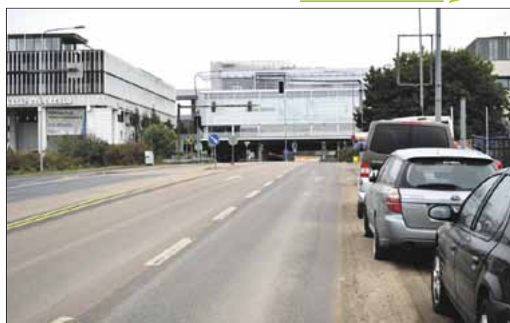
Tapiolan keskuksen purkamisen alkaa ja matalien rakennusten paikalle tulee 12-kerroksisia tornitaloja.
