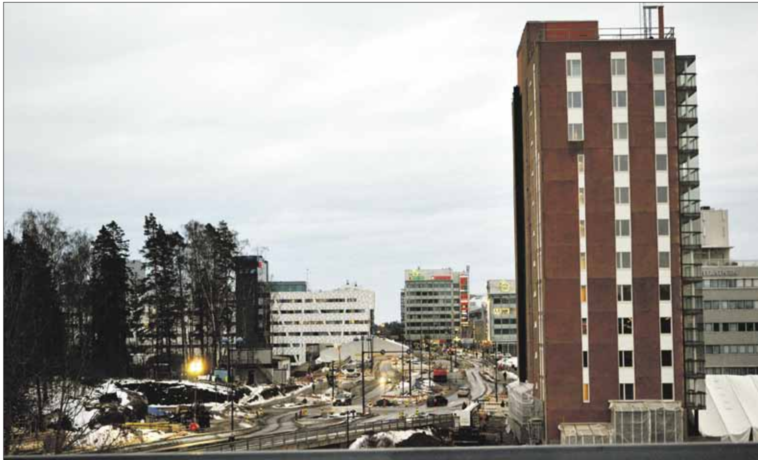
Matinkylän metroaseman tuntumaan Ison Omenan lähietäisyydelle rakennetaan 700 asuntoa.
